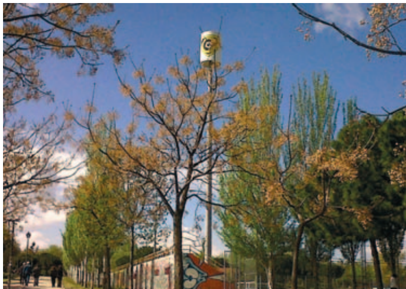
Antena mimetizada con el entorno.
